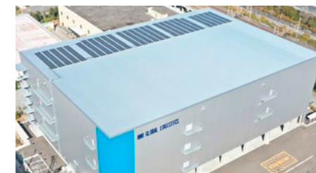
■ 屋上太陽光パネル
