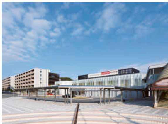
サンカルナ テラス 三国が丘駅前
