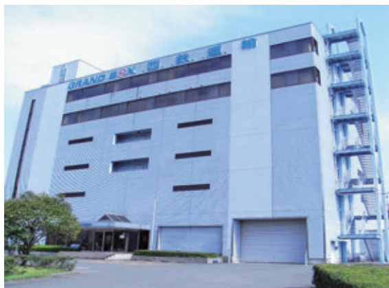
西鉄運輸本社と国際物流事業本部九州統括営業所が入居するグランドボックスビル
