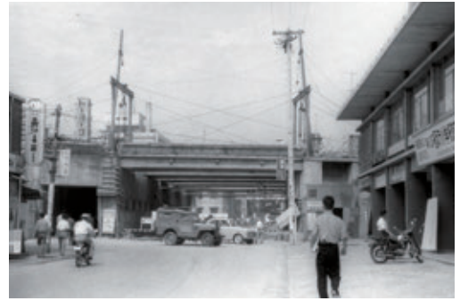
福岡スポーツセンター前から見た高架化工事の様子 (山本魚睡コレクションより)
