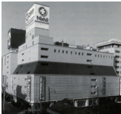
天神第1名店ビル(『因幡町商店街35年史』より)
