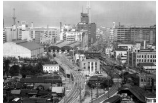
高架化工事竣工直前
