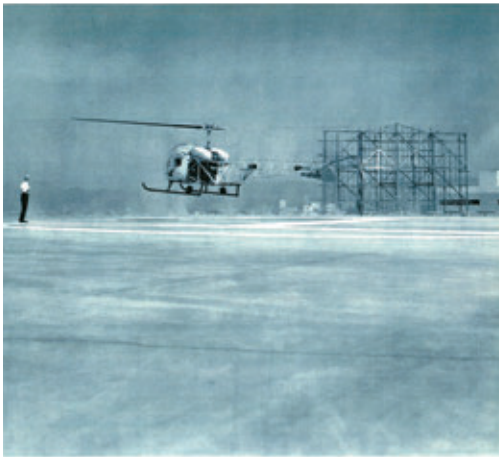
福岡ビル屋上ヘリポートでの試験飛行
