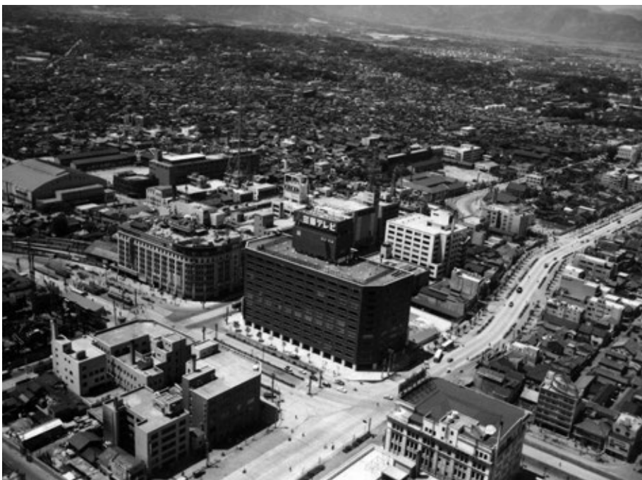
完成した天神ビル(中央)(提供:益田啓一郎)
