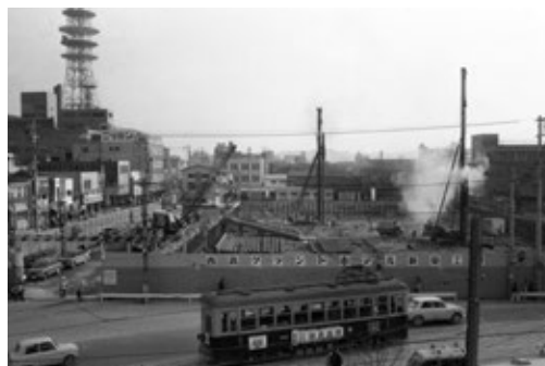
福岡市内線と建設中の西鉄グランドホテル
