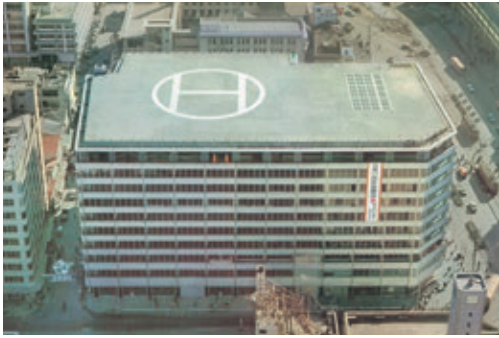
福岡ビル(竣工時全景)
