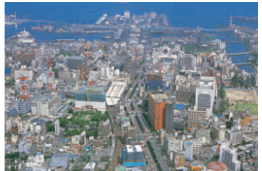
建設中のソラリアプラザビル
