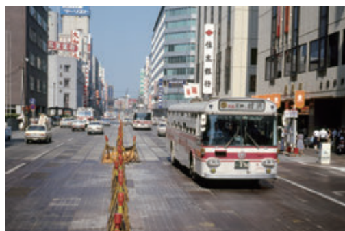
代行バスと地下鉄工事
