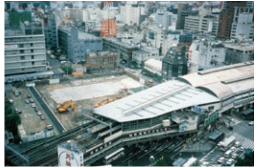
着工時のソラリアプラザビル
