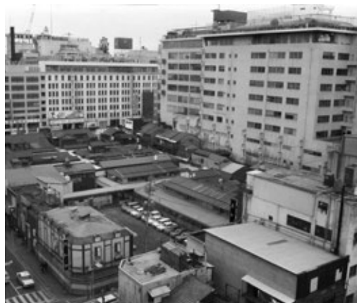
解体前の西鉄街 因幡町商店街
