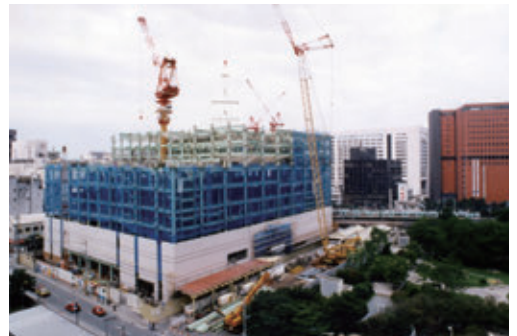
建設中のソラリアプラザビル
