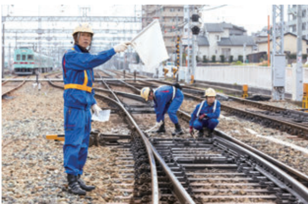
西鉄電車の安全走行を陰で支える保線業務
